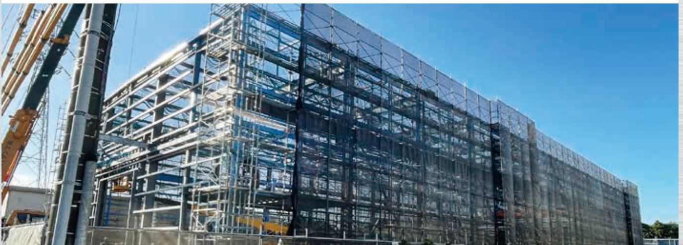
千葉第三工場の施工が始まっています
